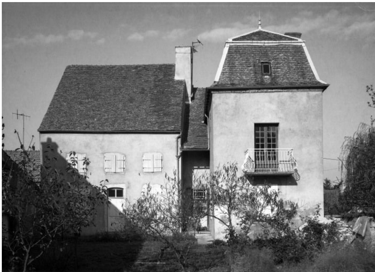
Vue d'ensemble d'une maison (cad. 1978, sect. AI, parc. 80).
