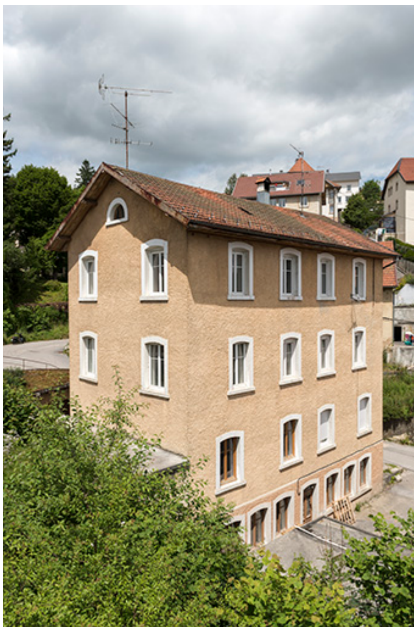
Façades postérieure et latérale droite.
