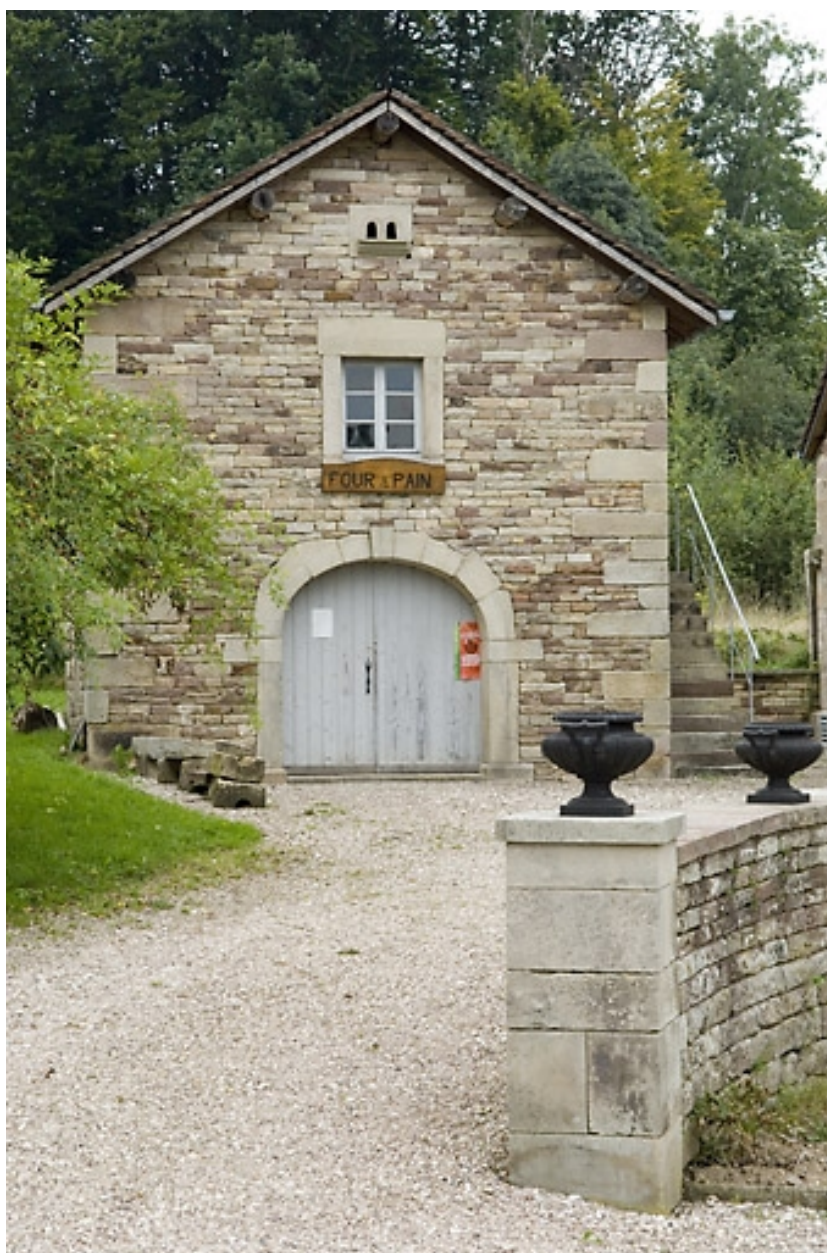
Four à pain. Vue de face.
