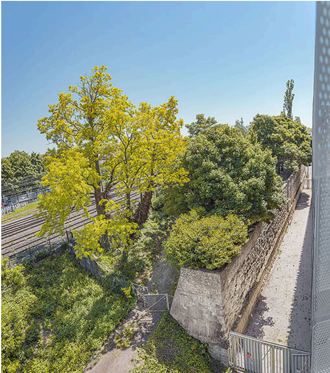
Le talus du bastion, socle des voies ferrées.
