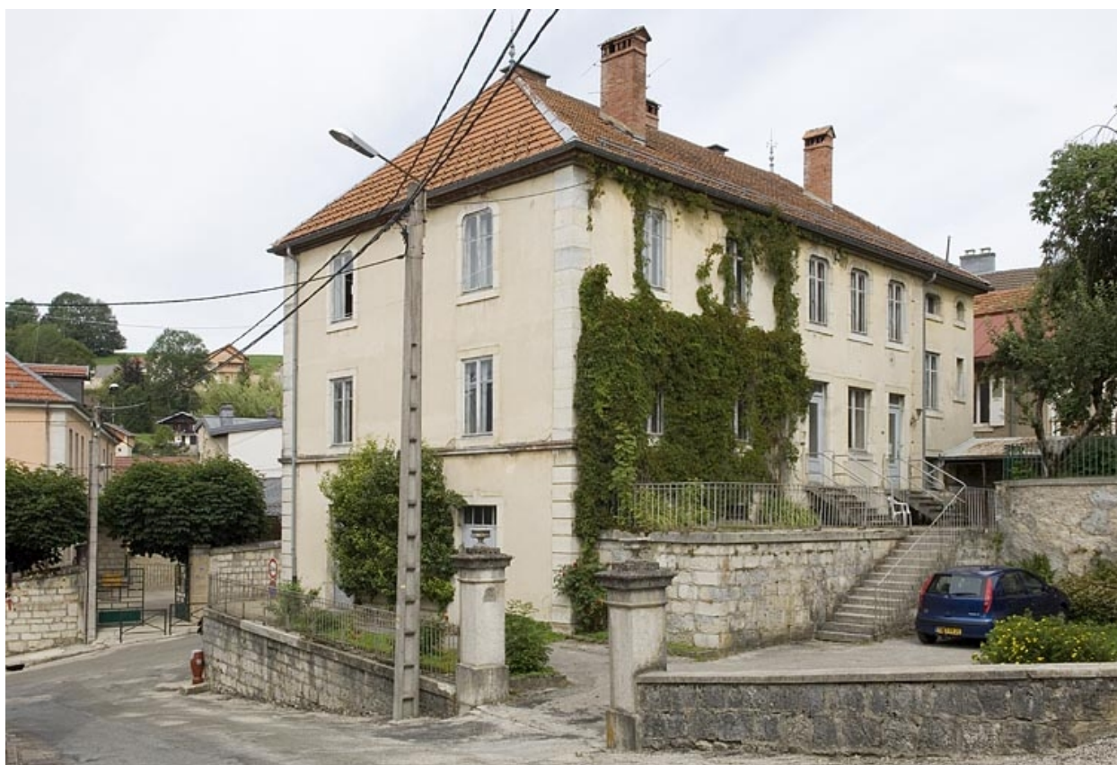
Façades postérieure et latérale droite.
