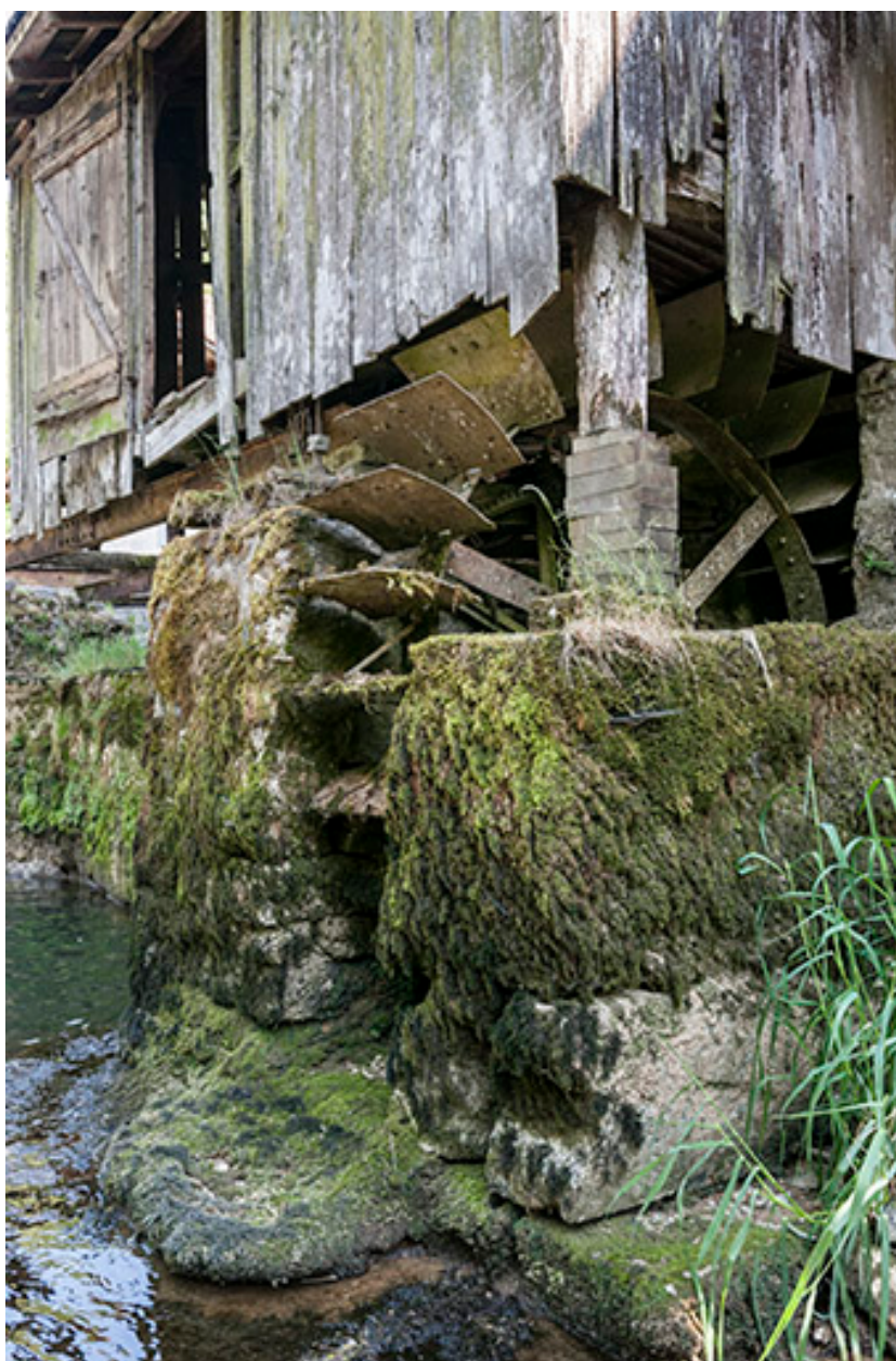
Bâtiment d'eau. Roue en dessous.
