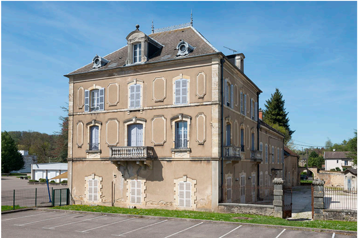
Corps de bâtiment sud, vue de trois-quarts gauche.
