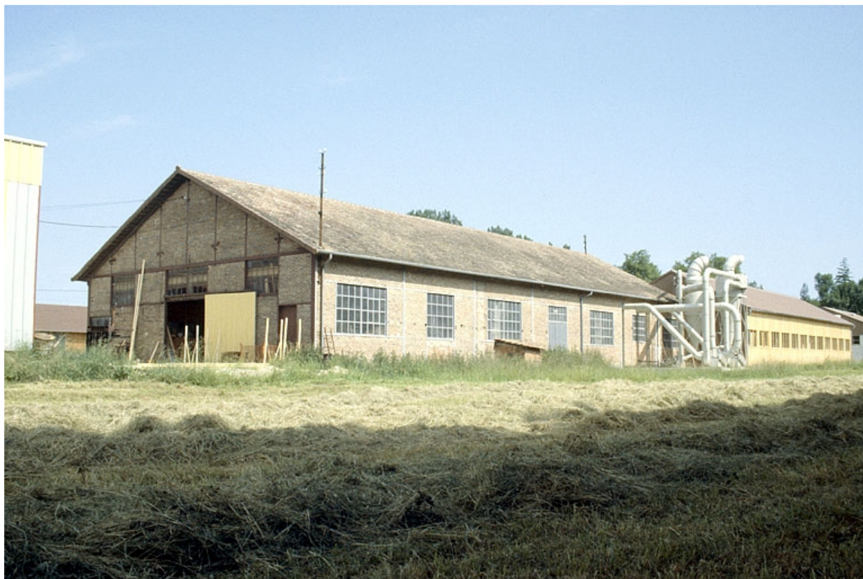
Atelier de fabrication (K), depuis le sud.
