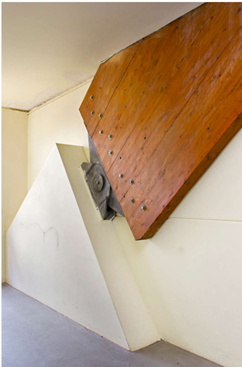
Atelier : charpente, détail.
