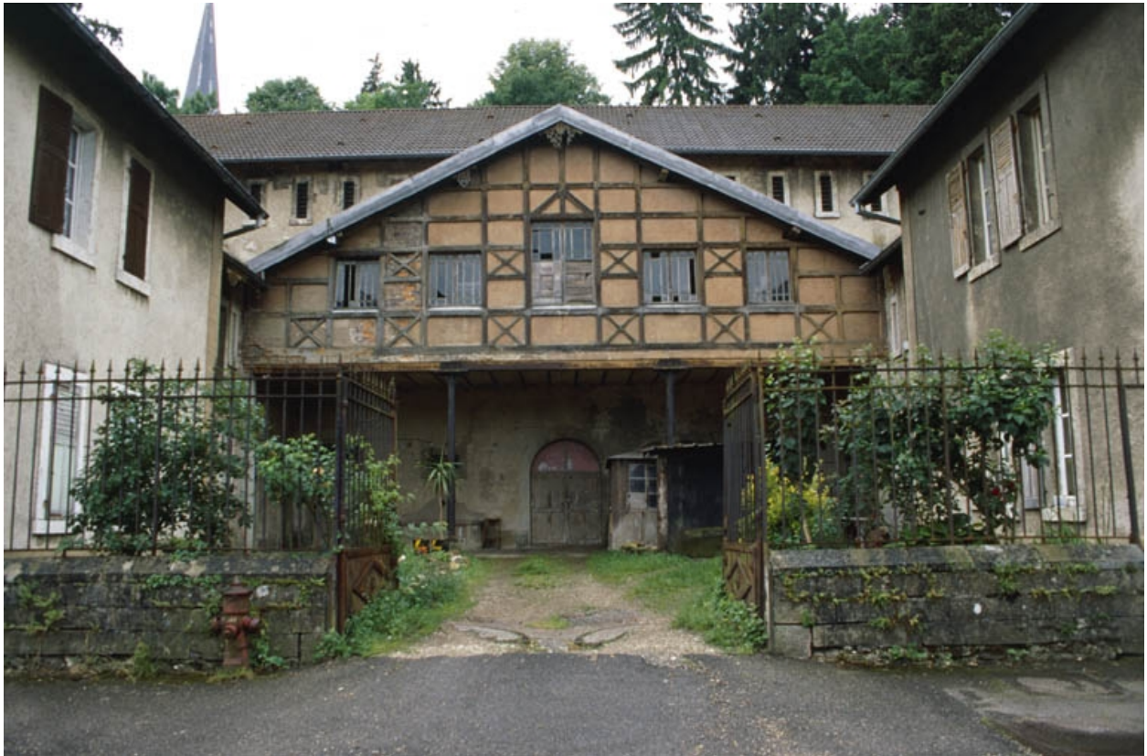
Façade nord de l'écurie.
