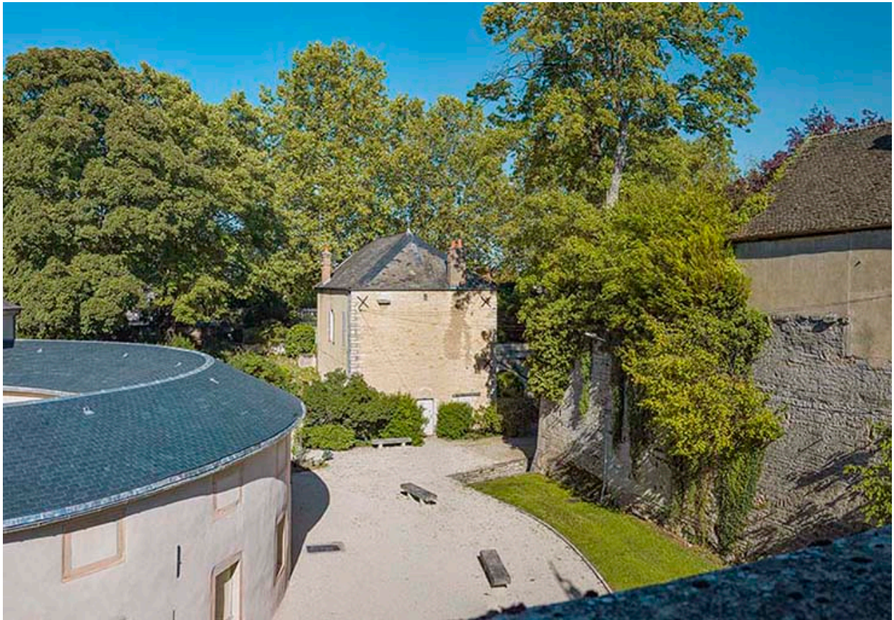
Flanc ouest du bastion.
