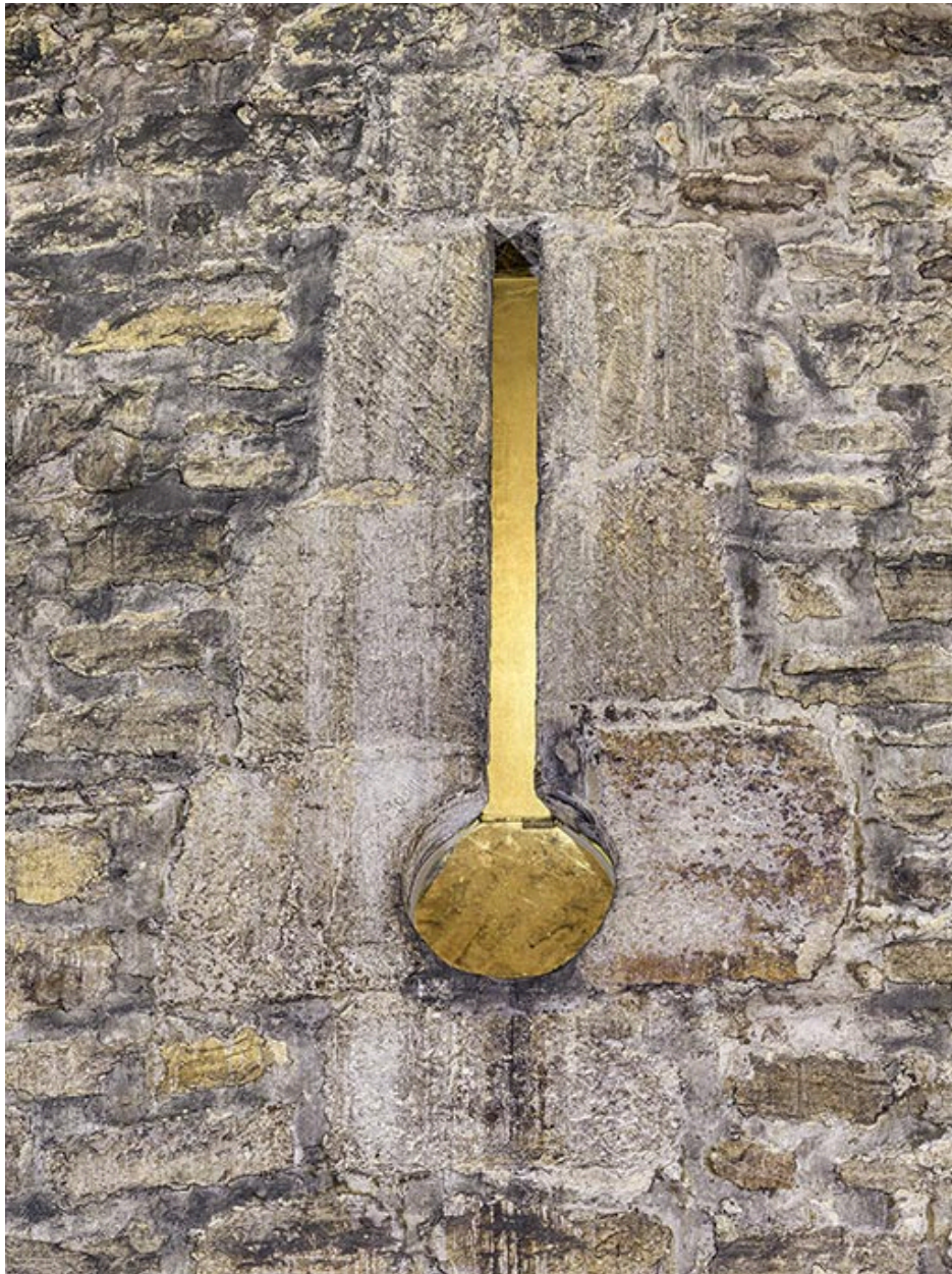
Détail de l'archère-canonnière.
