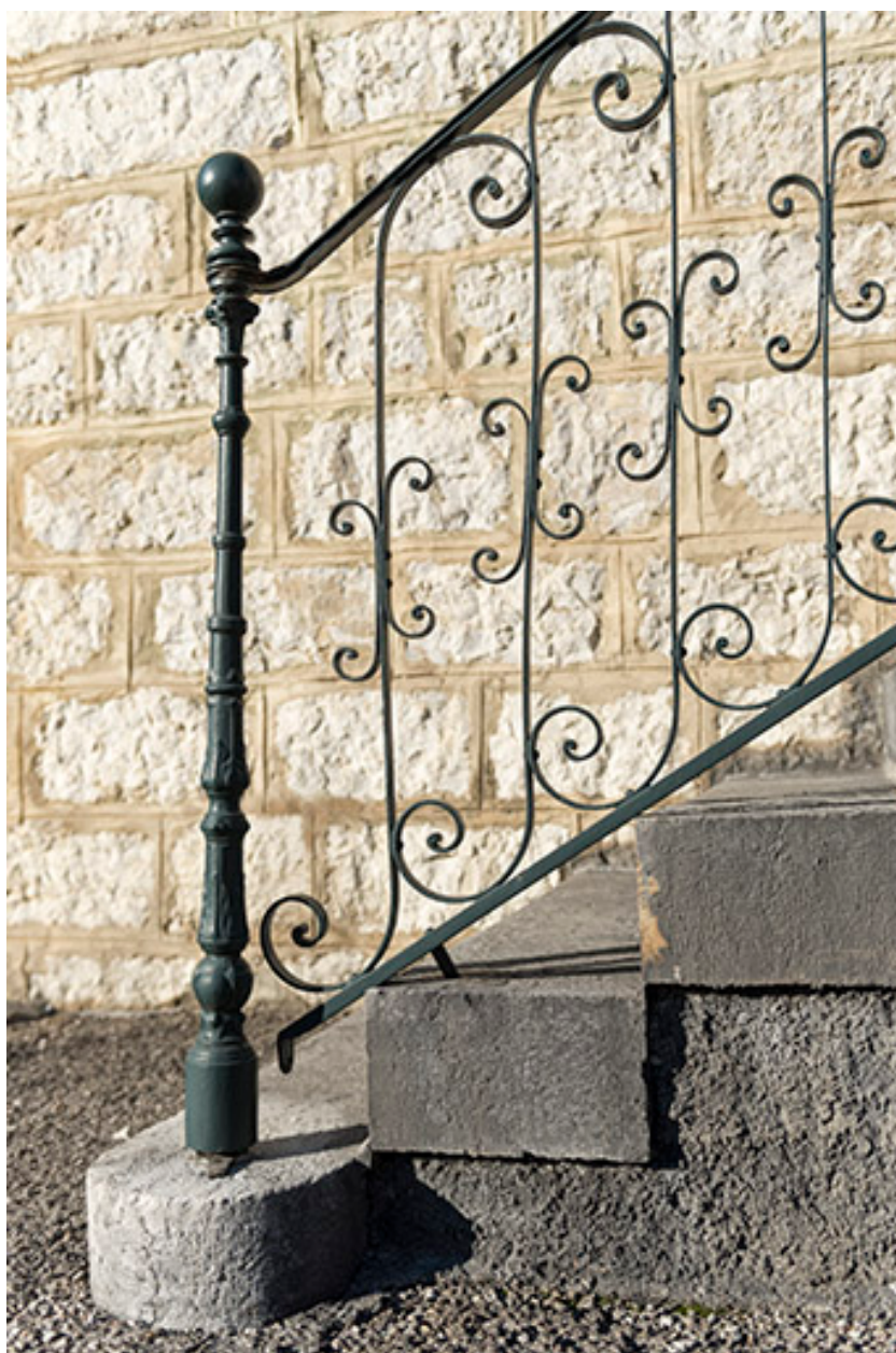
Façade antérieure : garde-corps de l'escalier.
