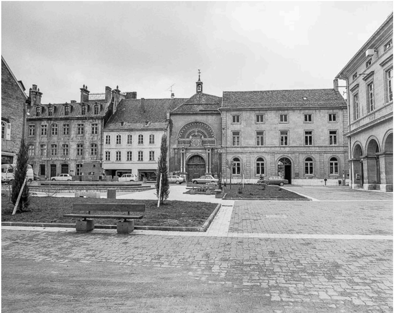
Vue d'ensemble de la chapelle.
