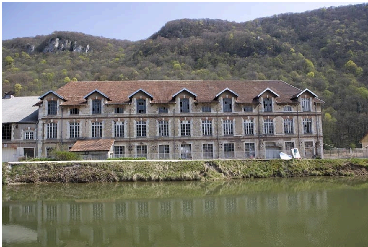
Façade antérieure de l'atelier de façonnage.
