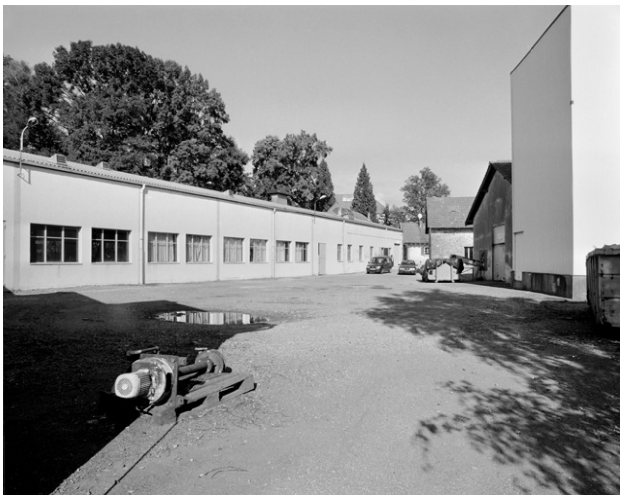
Atelier de fabrication depuis le sud-est.
