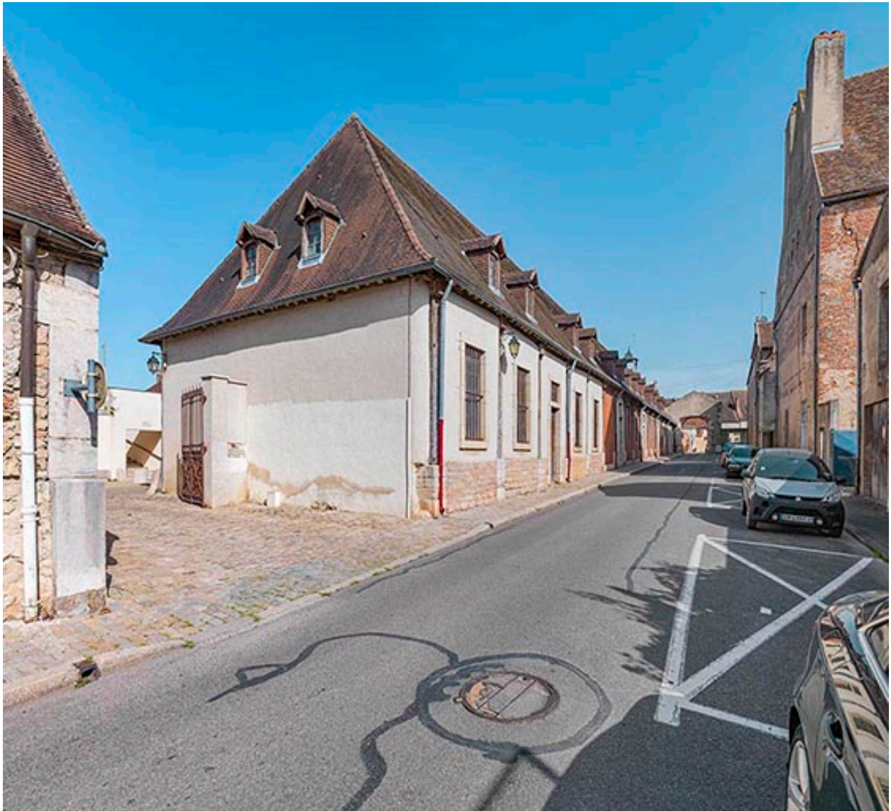
Le hangar depuis la rue des Halles.
