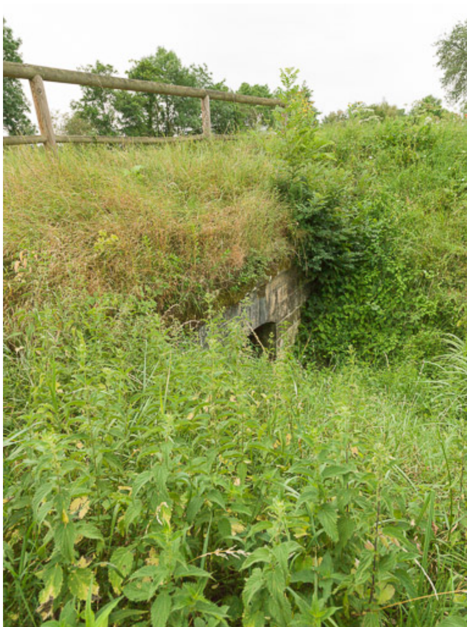
Vue de l'aqueduc.
