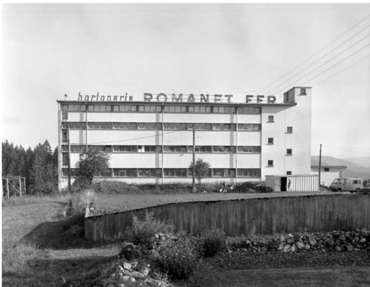
Façade postérieure du bâtiment de 1961.
