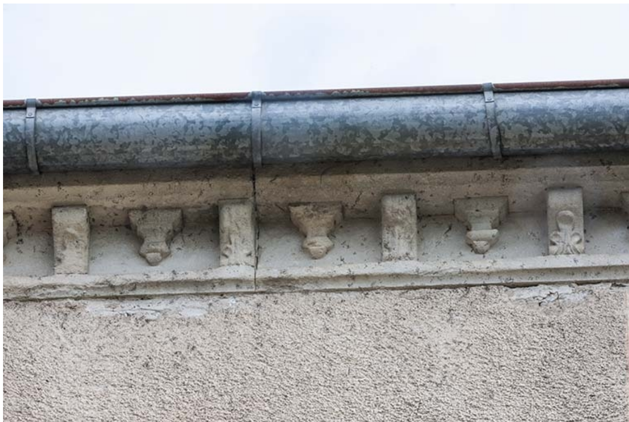
Détail de la corniche de la maison.
