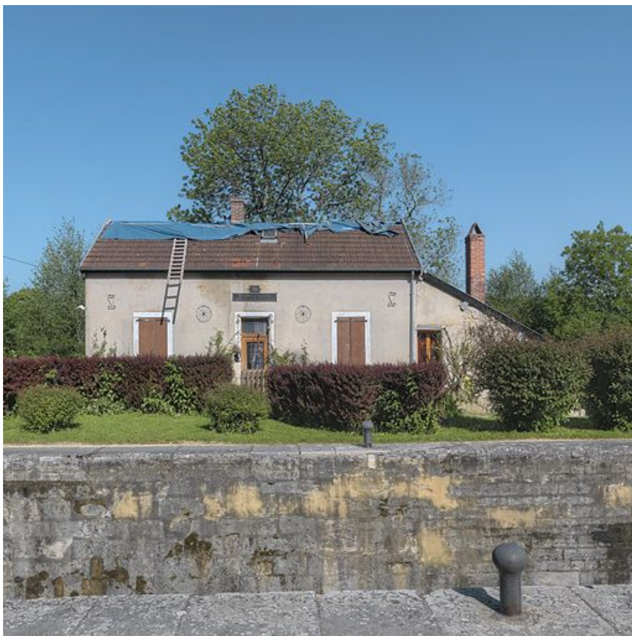
Maison éclusière de face.
