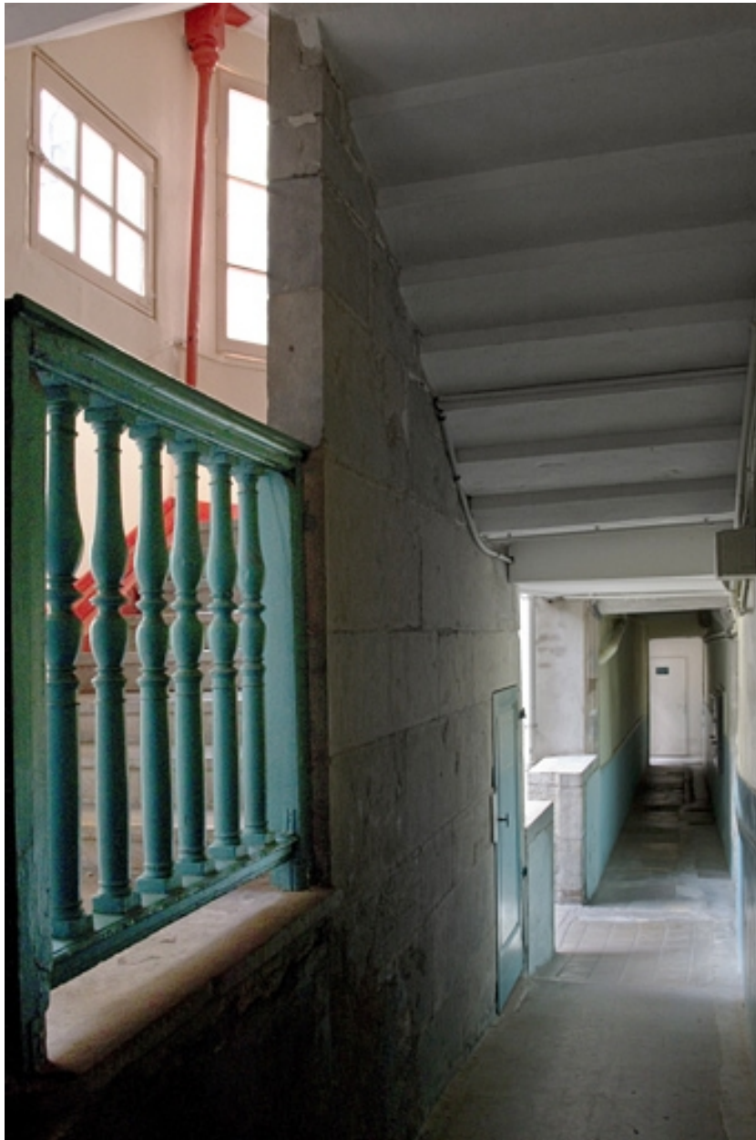
Logis principal, couloir : détail du passage sous l'escalier à cage ouverte.
