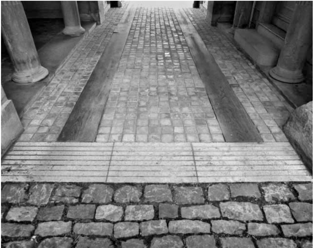
Passage d'entrée : détail du revêtement.
