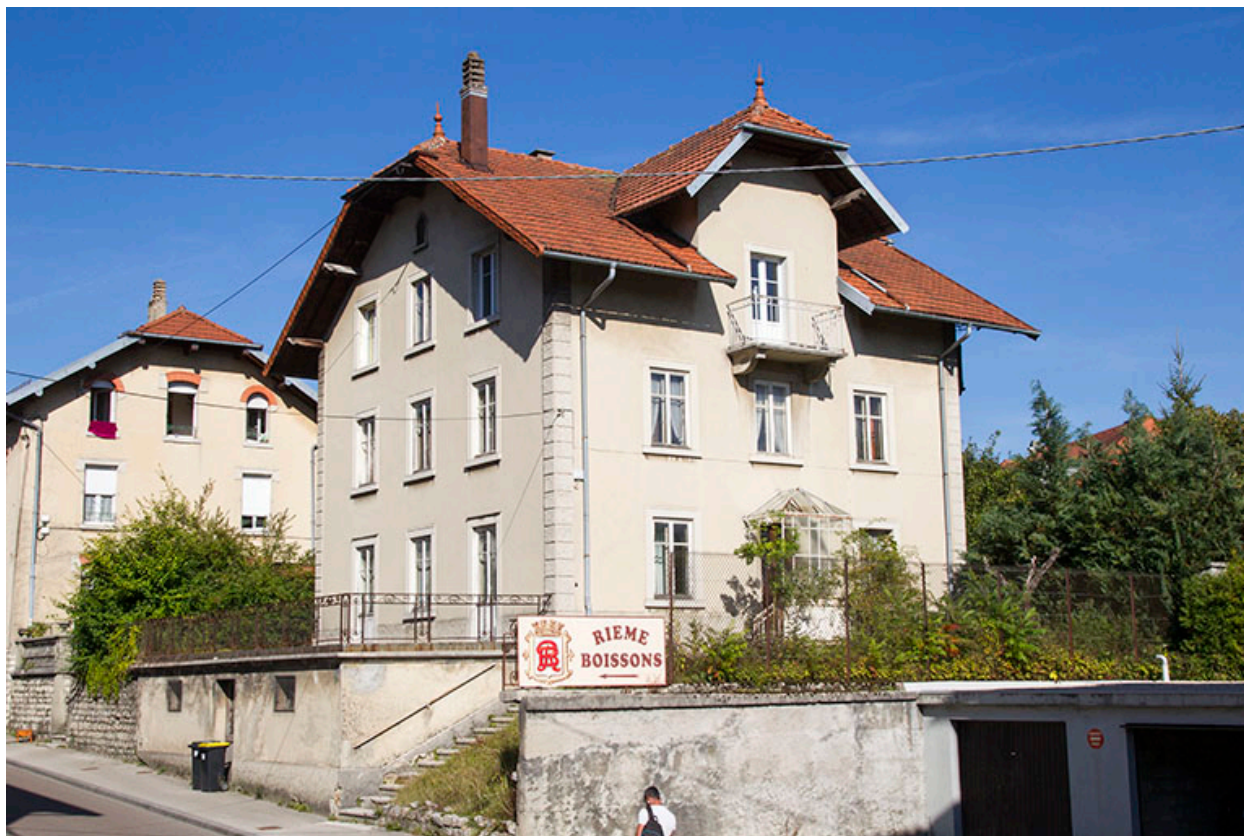
Façades antérieure et latérale droite.
