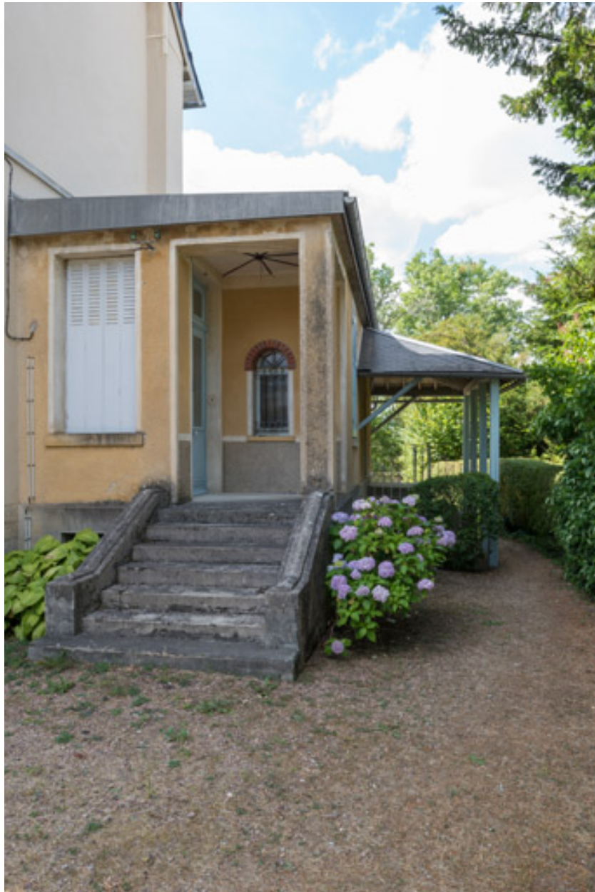
Entrée latérale, côté nord.
