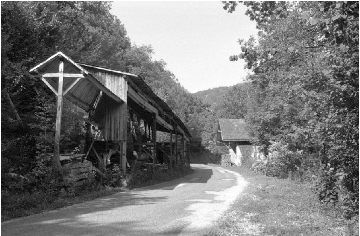
Séchoir à bois et magasin industriel.
