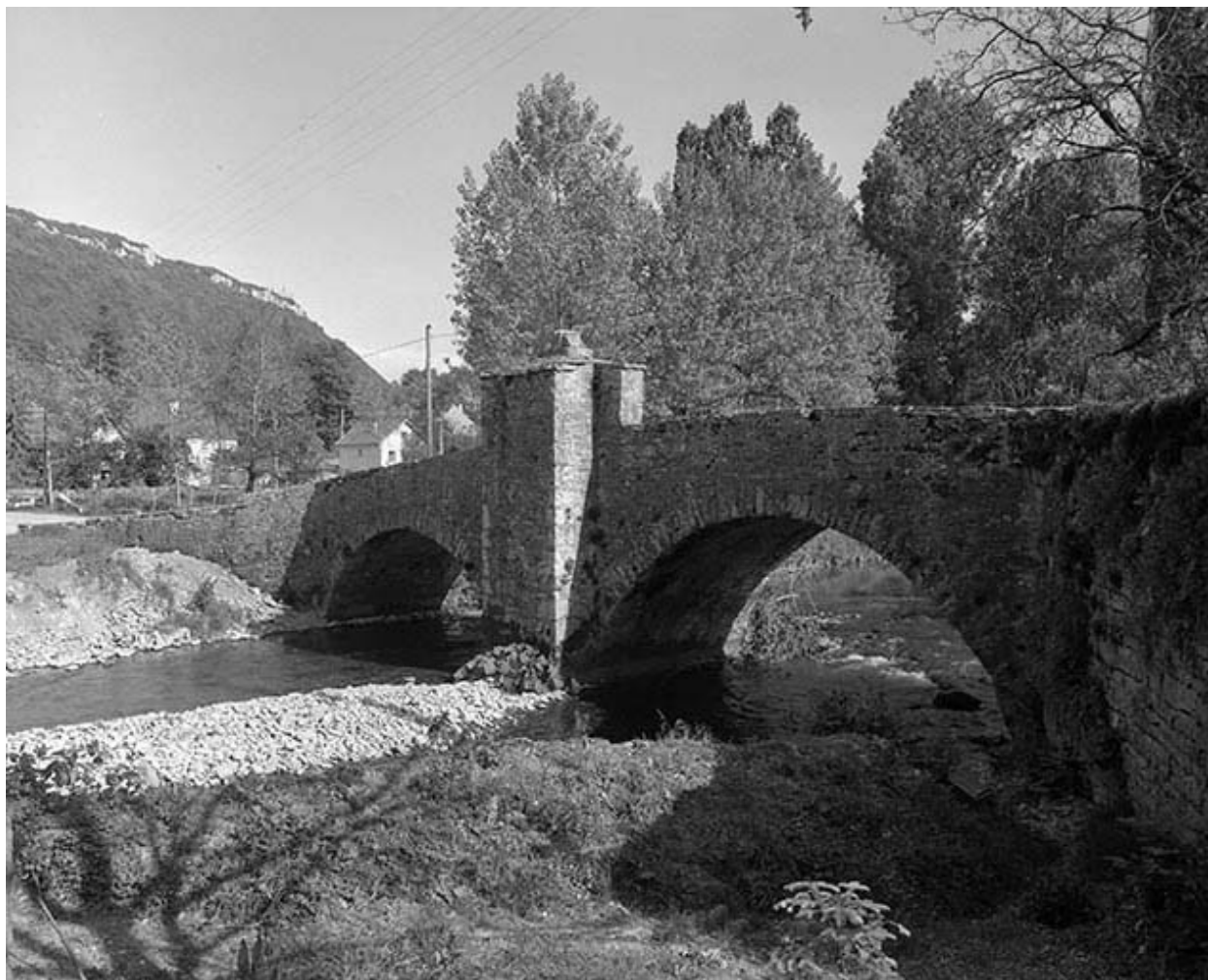
Face aval de trois quarts droit.
