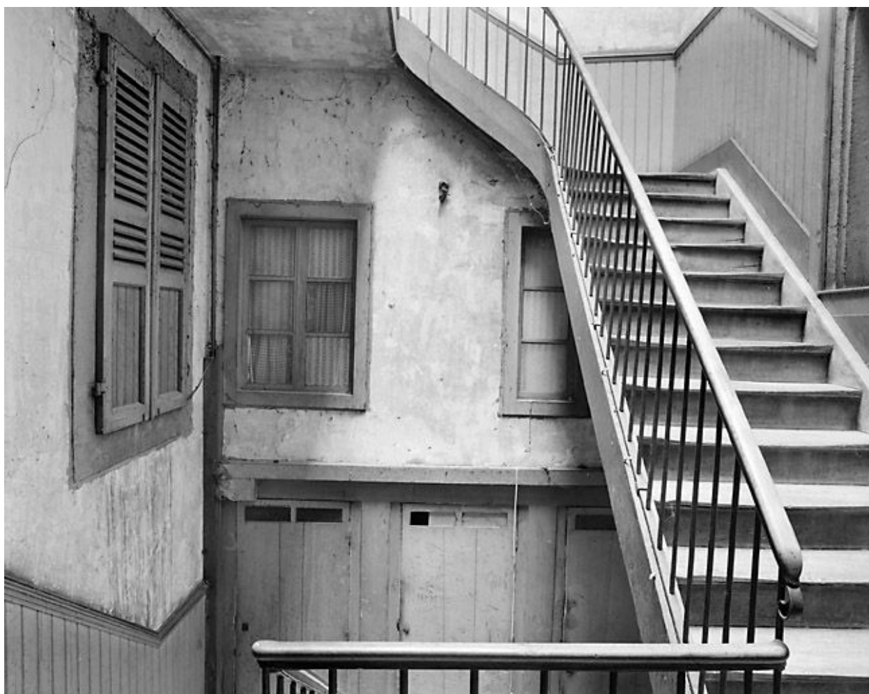
Cage d'escalier, au premier étage.
