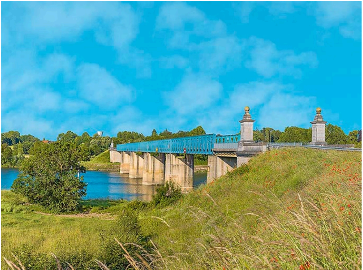
Vue d'ensemble du pont, d'aval.
