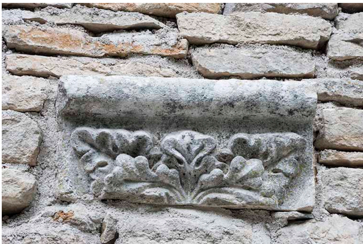
Fragment d'un chapiteau, façade côté cour.
