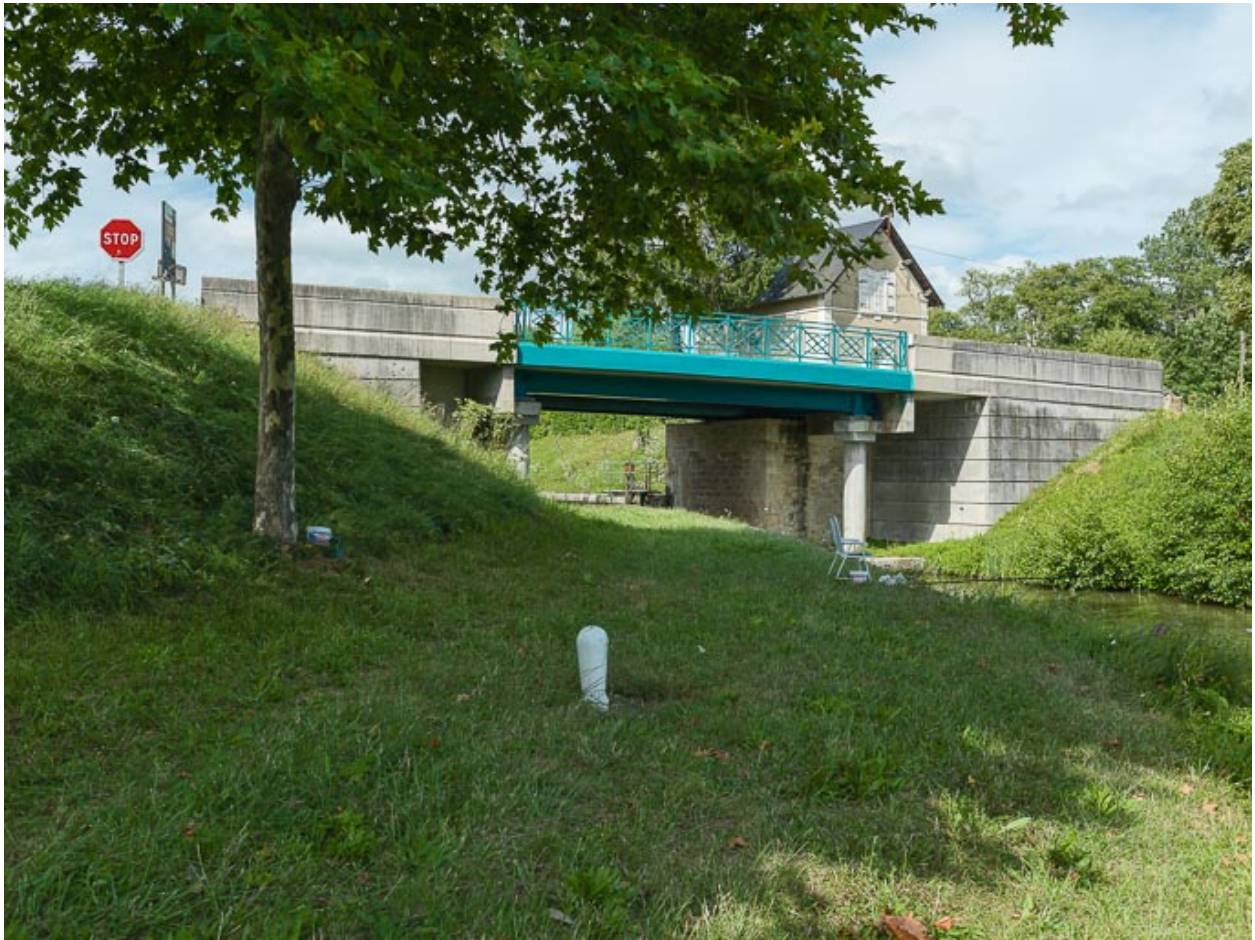
Vue d'ensemble du pont.
