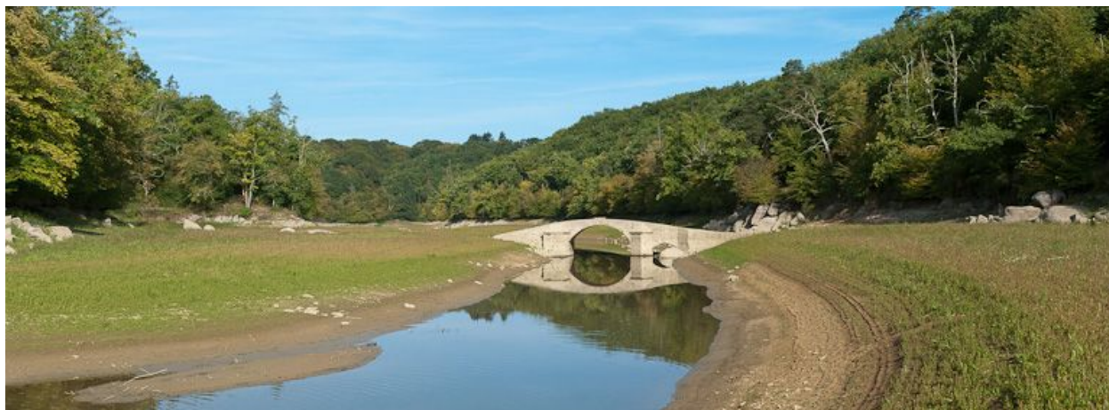
Vue du pont.
