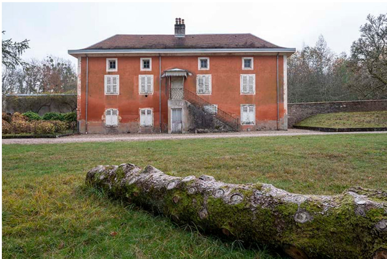
Façade nord, vue d'ensemble.
