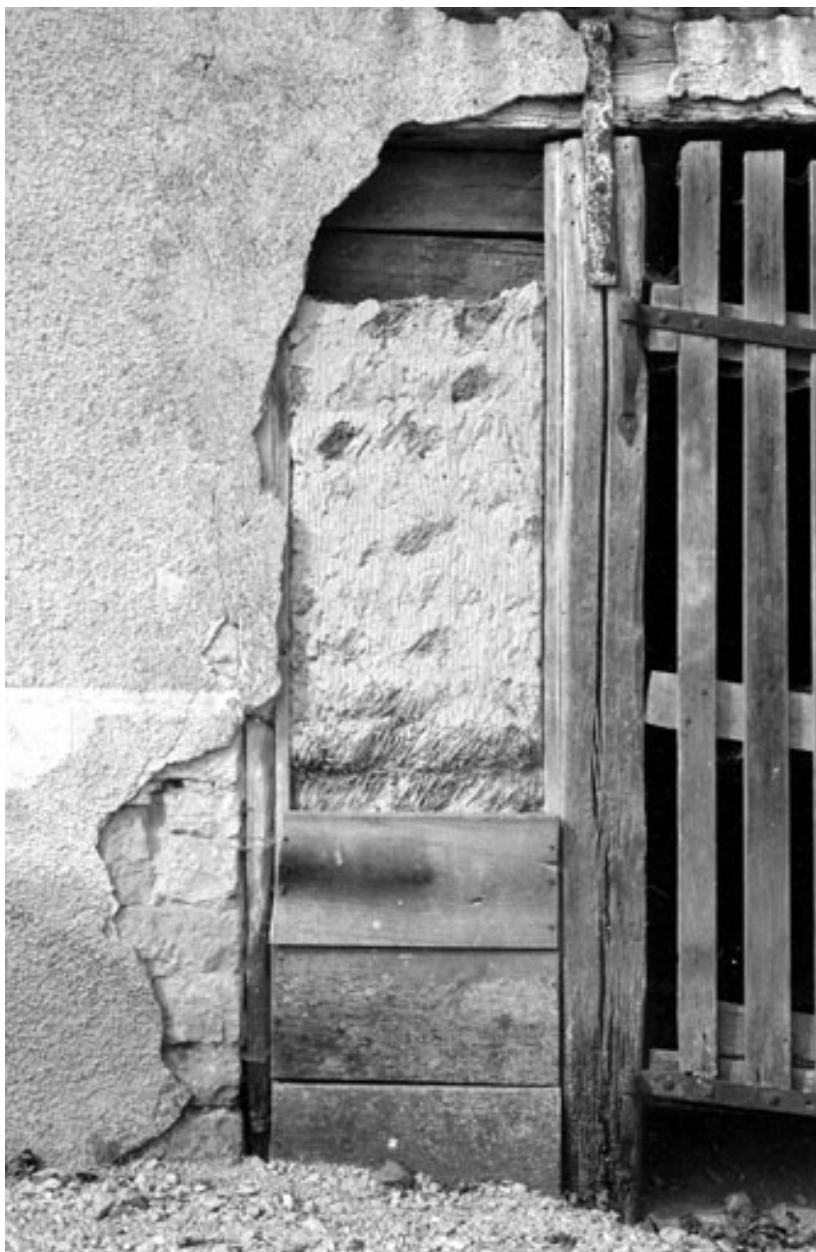
Détail : matériaux de construction.
