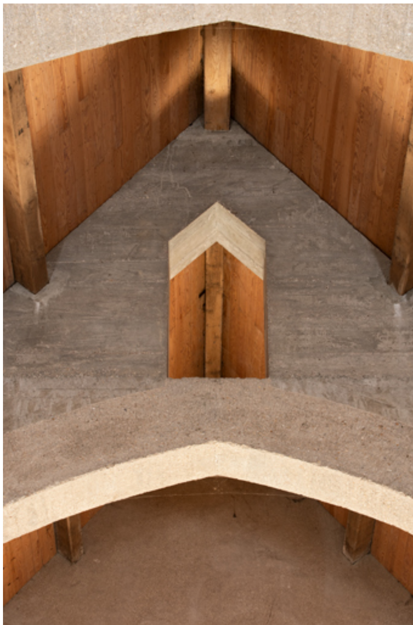
Charpente, détail d'un arc en béton armé.
