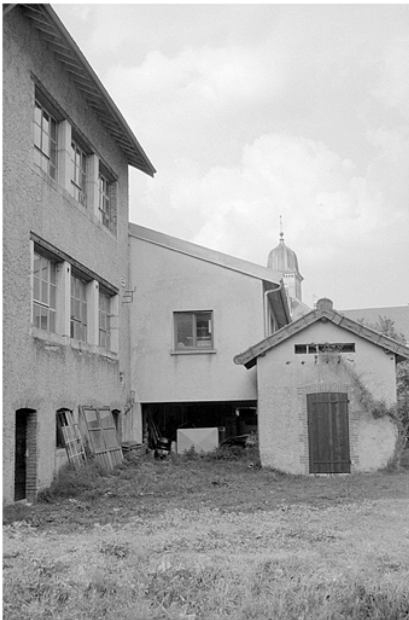
Façade postérieure et transformateur.
