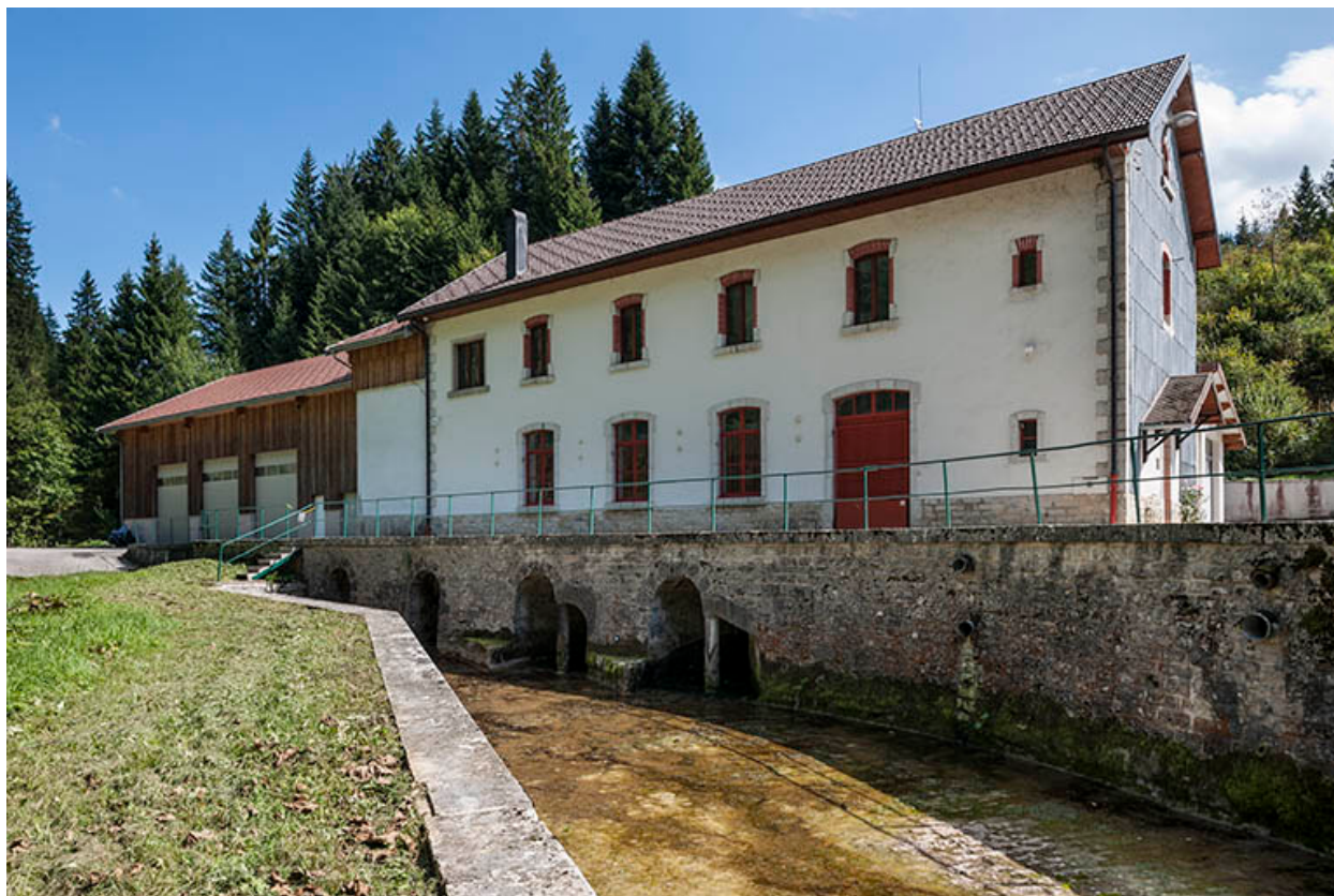
La centrale et le canal de fuite.
