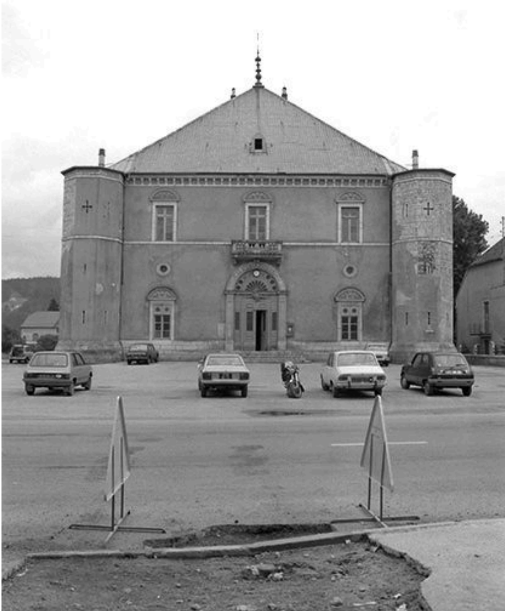
Façade antérieure, vue de face.
