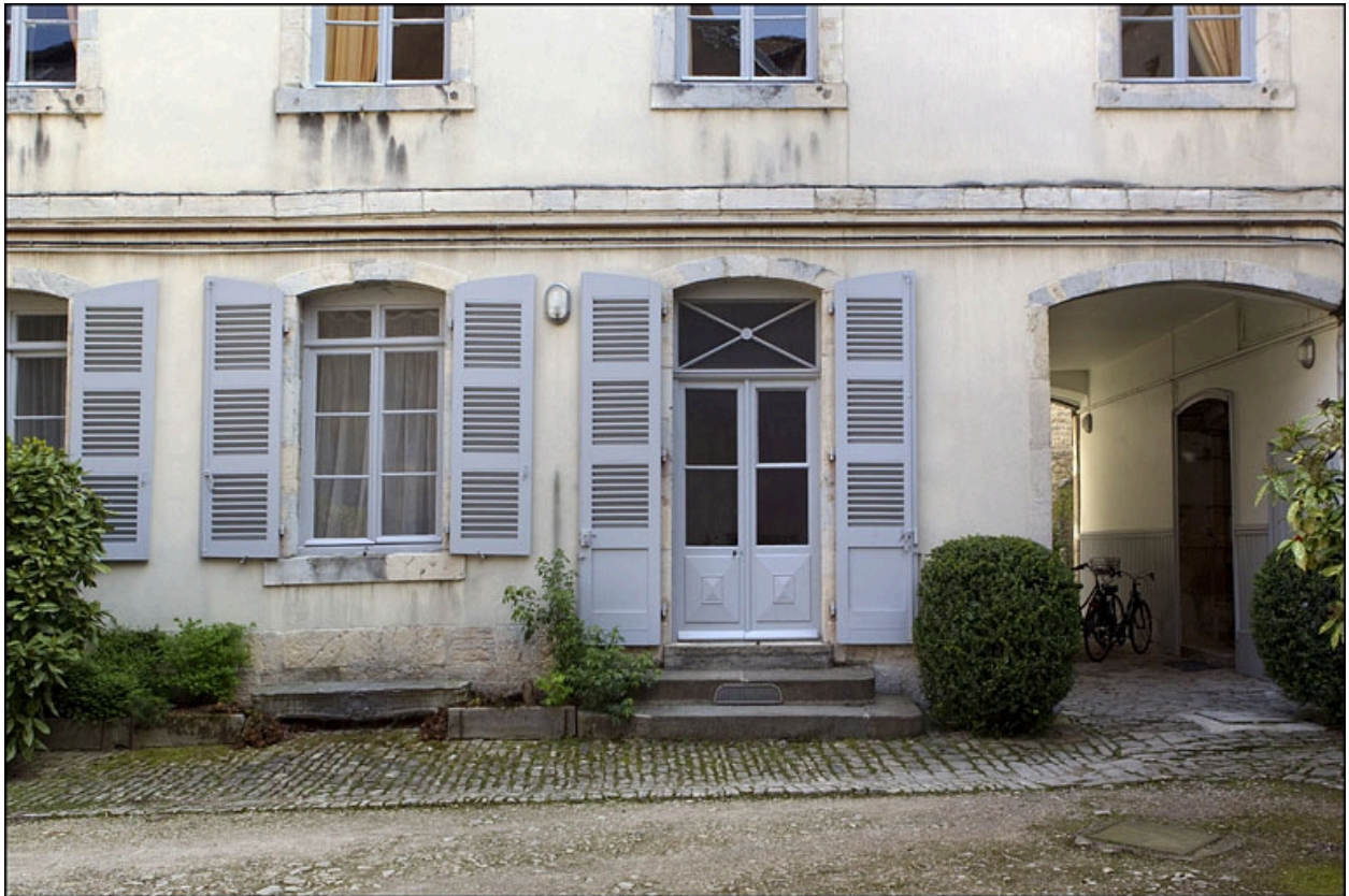
Détail du rez-de-chaussée de l'aile gauche du logis secondaire.
