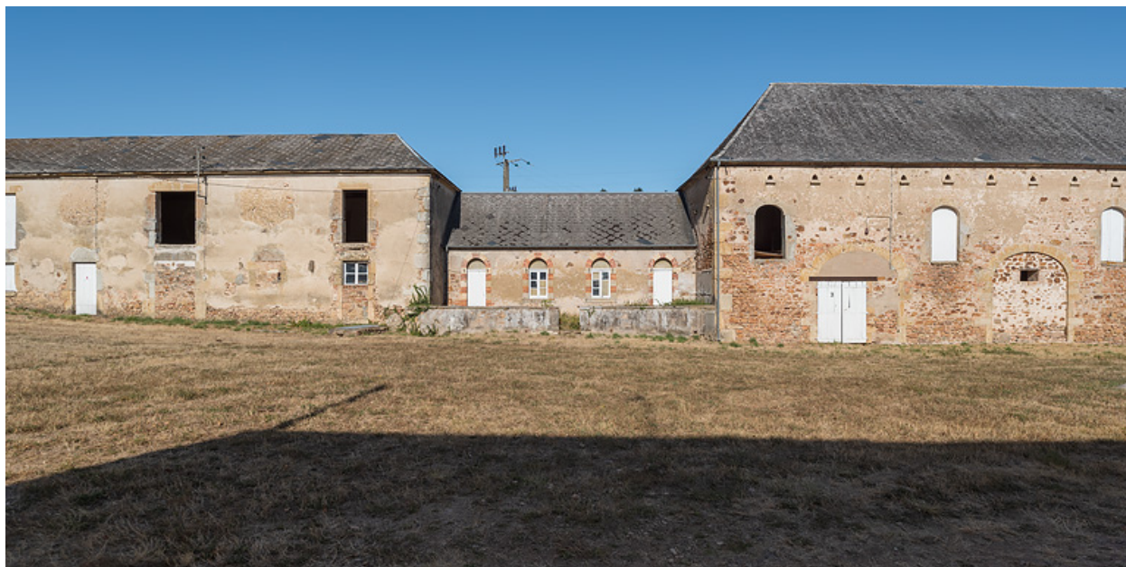
Bâtiment des dépendances.
