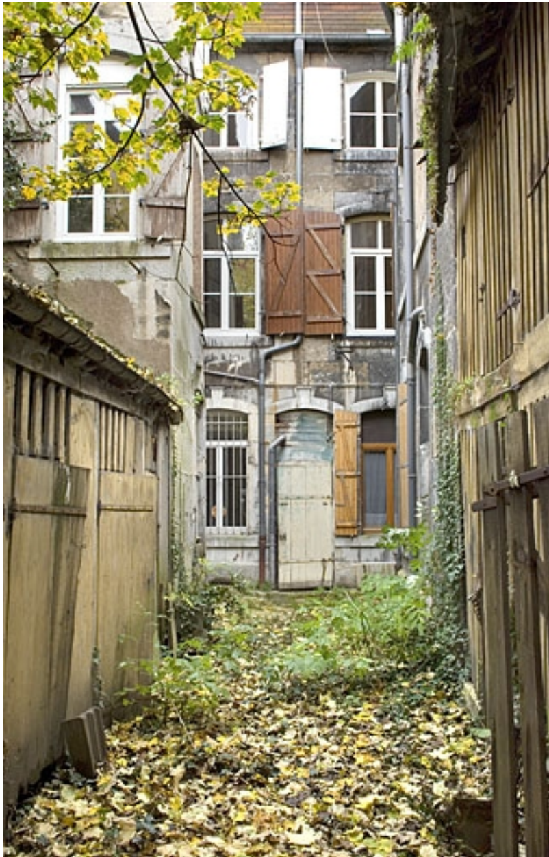
Vue d'ensemble de la façade postérieure du logis secondaire depuis le fond de la deuxième cour.
