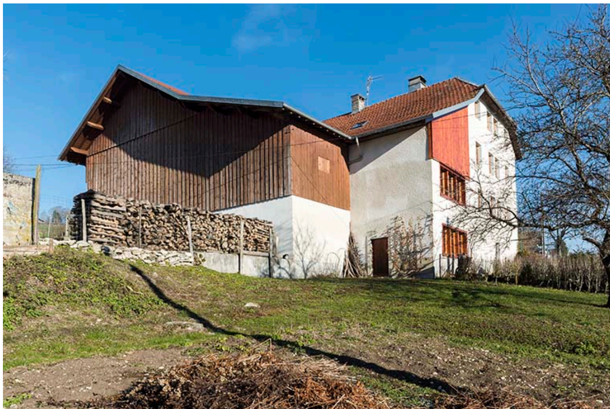
Façades postérieure et latérale gauche.
