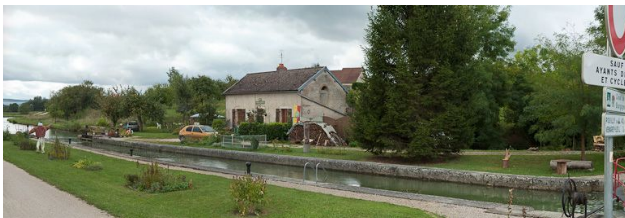
Vue d'ensemble du site d'écluse.
