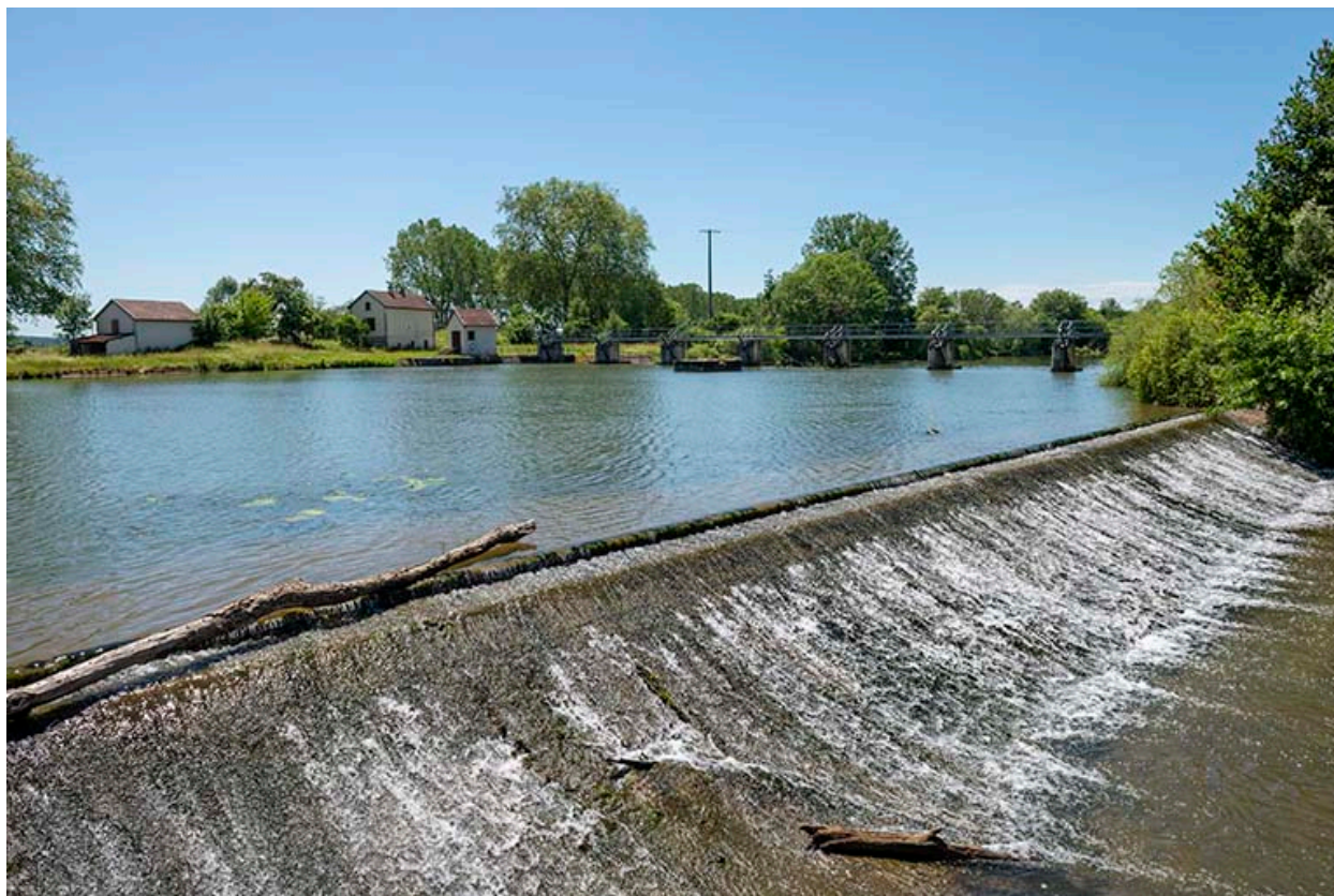
Vue de profil du déversoir et le barrage mobile en arrière-plan.
