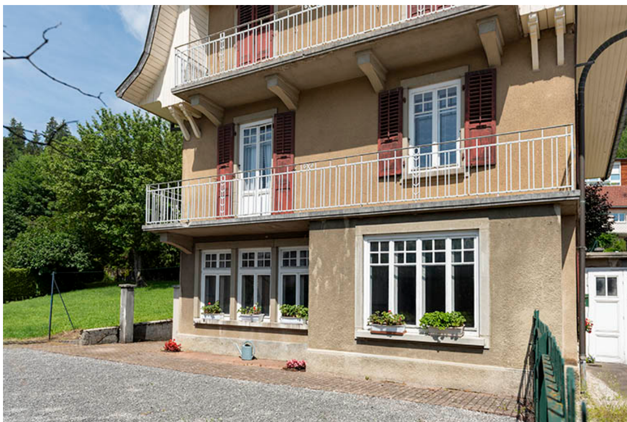
Façade antérieure : rez-de-chaussée et 1er étage.
