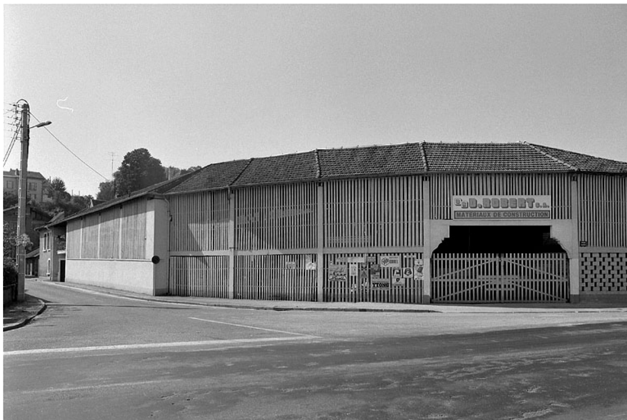
Vue d'ensemble des entrepôts depuis la rue.
