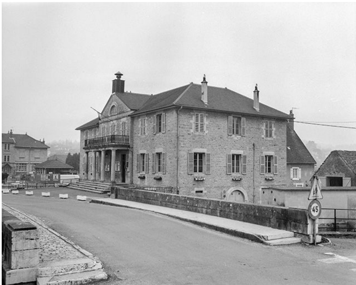
Façade antérieure et face droite.
