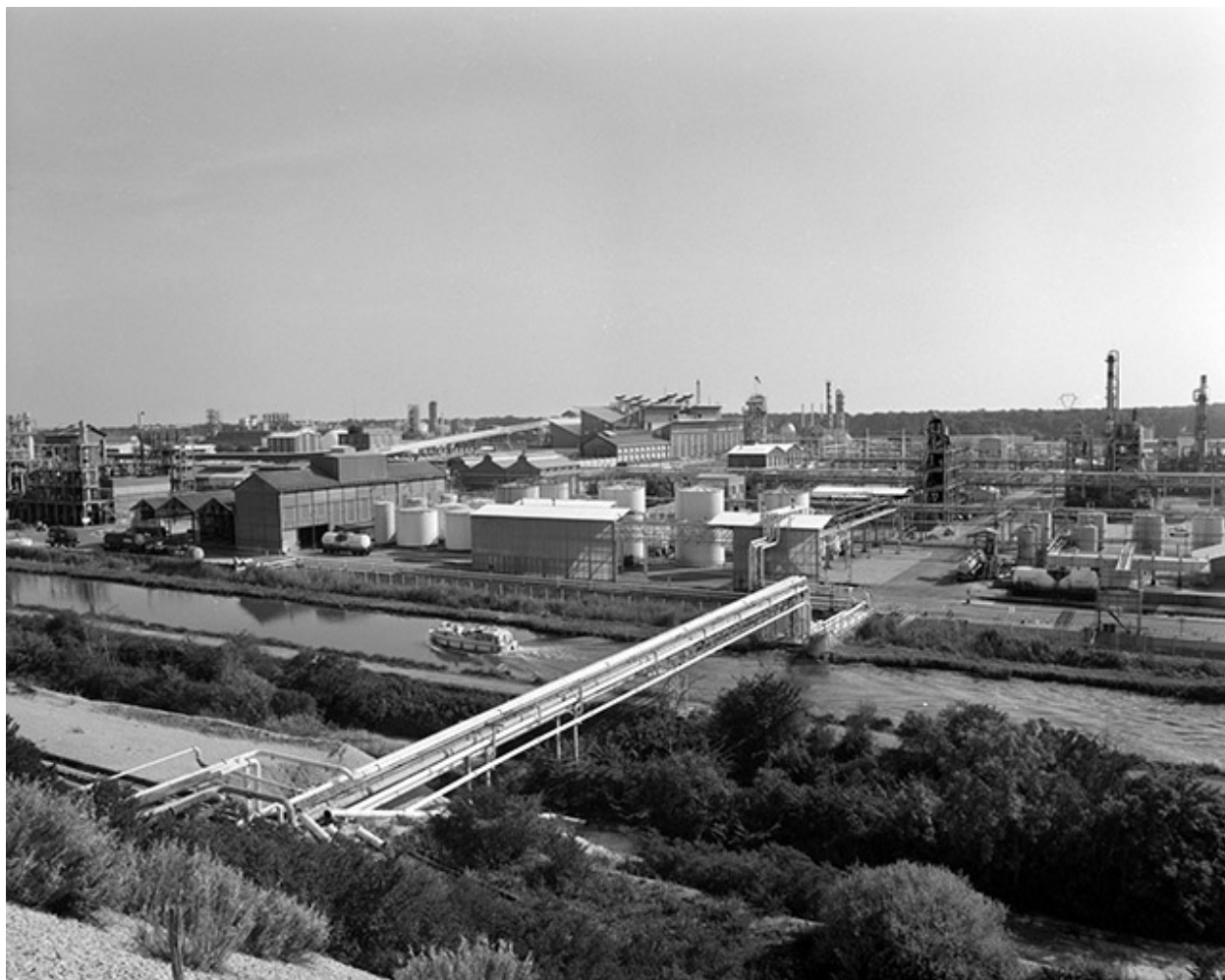
Division Electrolyse vue depuis le haut des bassins de décantation.
