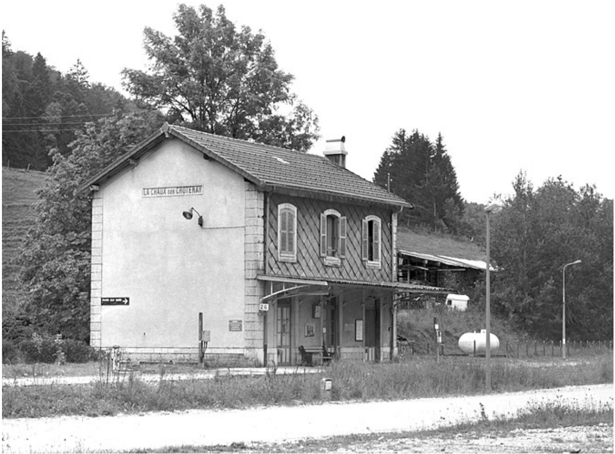
Bâtiment des voyageurs : façades postérieure (côté voie) et latérale gauche.
