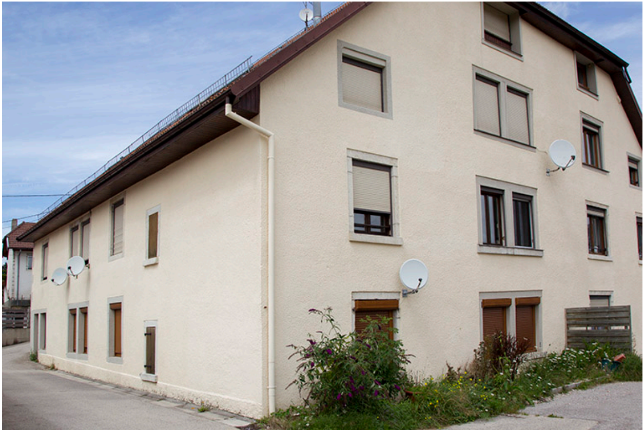
Façades postérieure et latérale droite.
